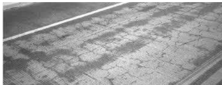
Gambar 2.7 Retak Susut
