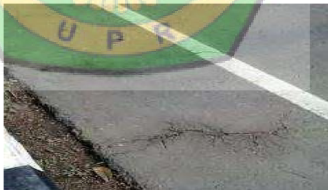
Gambar 2.3 Retak Pinggir
